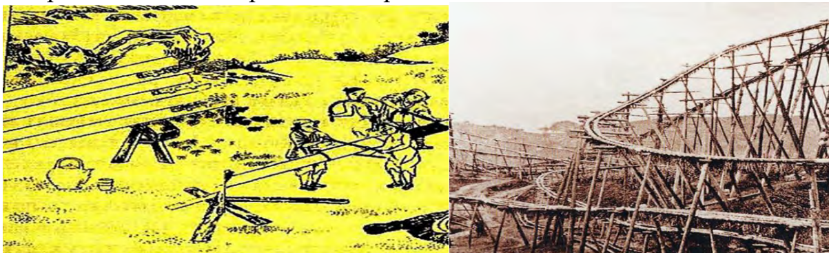
Рисунок 1. - Бамбуковый газопровод и его строительство
