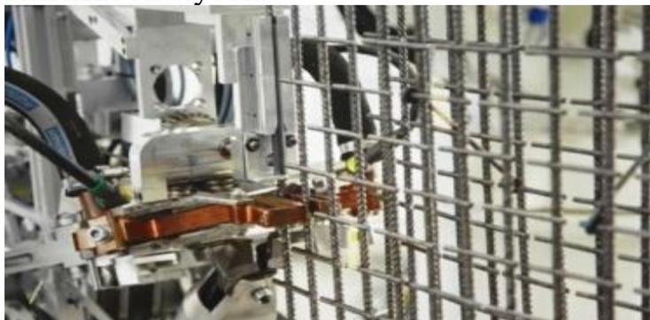
Рис.2 - Средства роботизации арматурных работ на объекте
