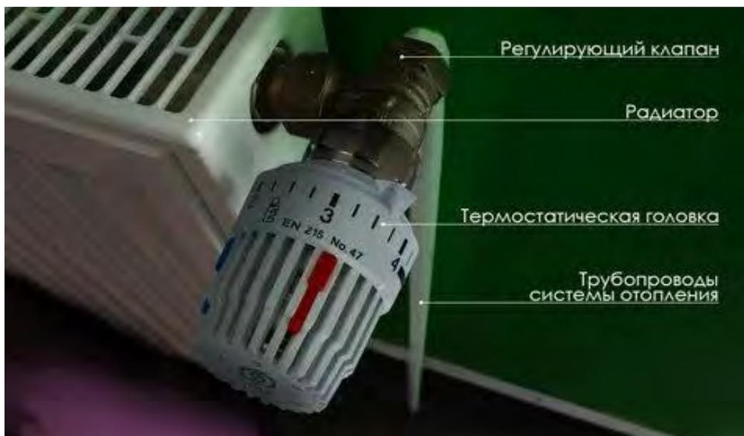
Рисунок 1 - Радиатор с вентилем
