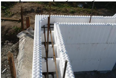
Рисунок 1 Пенополистирольная опалубка
