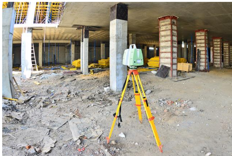
Рисунок 7. Проведение сканирования на строительной площадке
