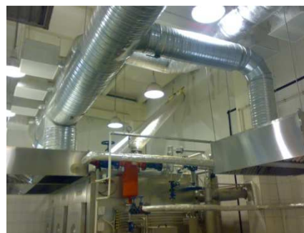
Рисунок 12 – Инженерные системы вентиляции.
