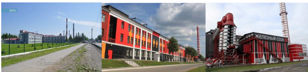
Рисунок 1 - Электросталеплавильный комплекс "Железный Озон 32" до и после реставрации
