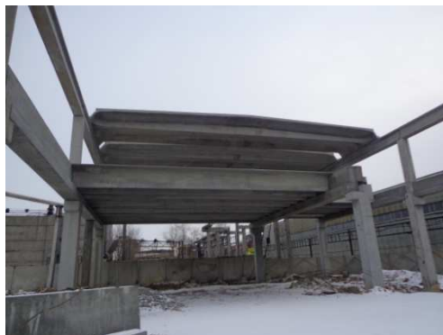
Рисунок 3 - Автокомплекс завода ЖБИ -1
