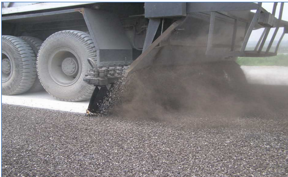
Рис. 2 - Распределение битумной эмульсии и россыпь щебня с помощью БЩР
