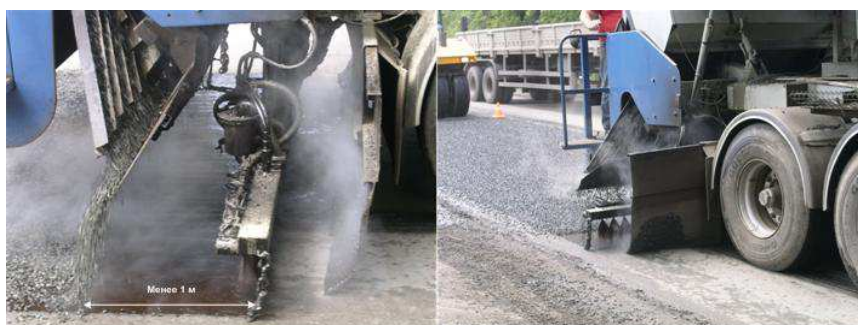
Рисунок 1 – Синхронный метод поверхностной обработки
