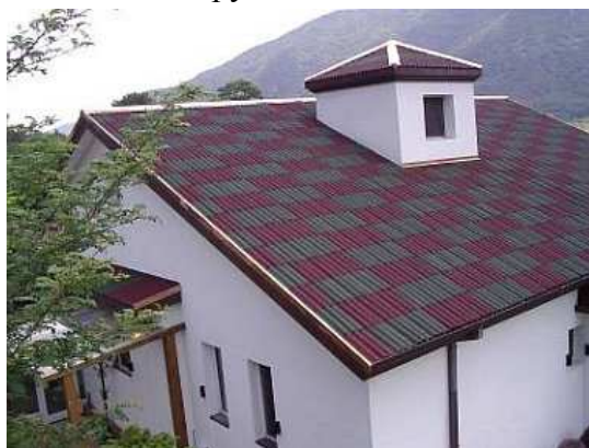
Рисунок 7 - Кровля из ондулина
