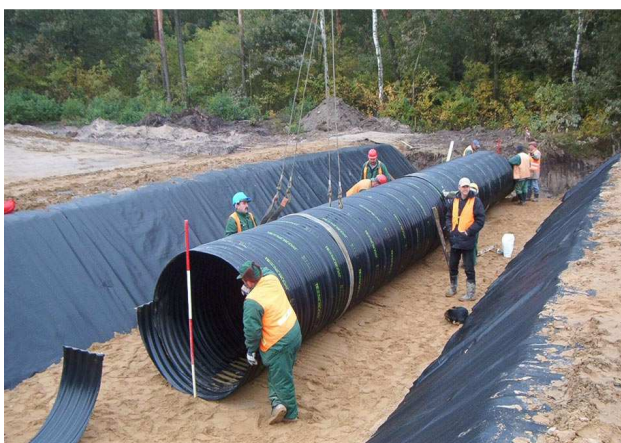
Рисунок 2 - Монтаж спиральновитых гофрированных металлических труб
