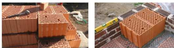
Рисунок 2. Кладка с использованием керамического блока
