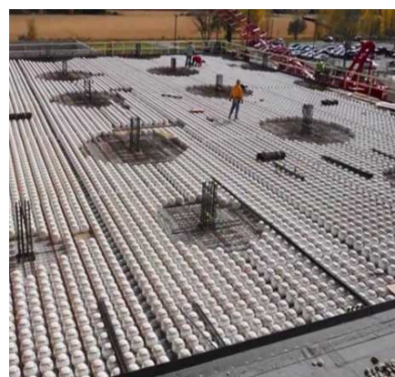
Рисунок 5 – Установленные панели Bubbledeck готовые к заливке бетоном
